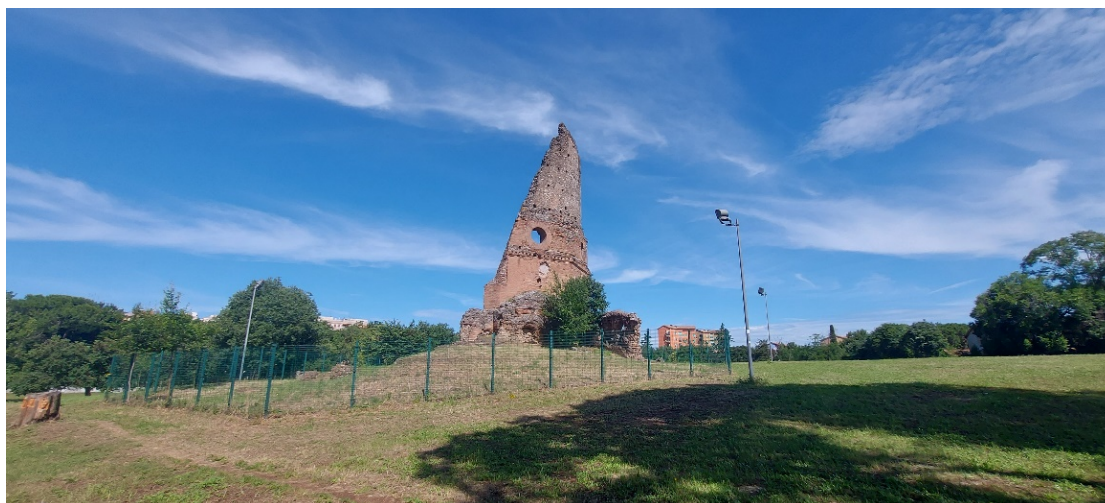
Cisterna Grande di Via Prenestina
