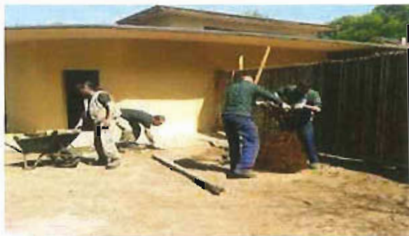
Lavori di preparazione di nuovi punti verdi nel recinto addax.
