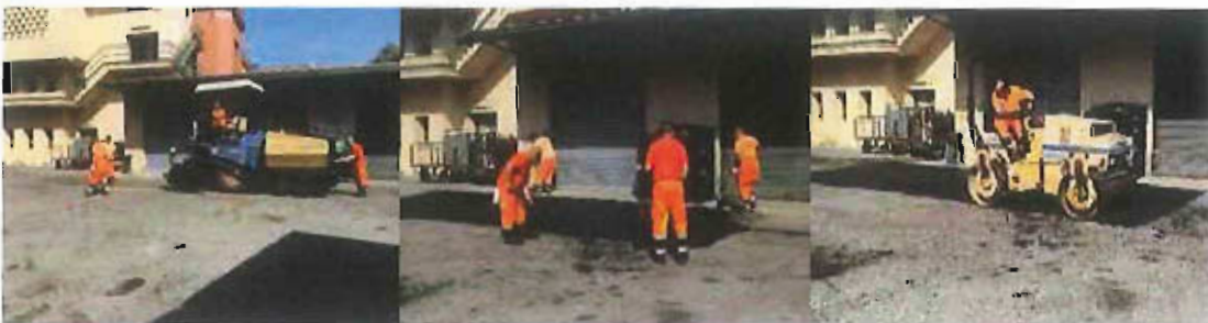
30. Riparazione tratta fognaria retro rettilario, presso la gabbia dei pappagalli;
