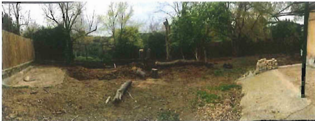
Lavori in corso nel nuovo recinto potamoceri.
