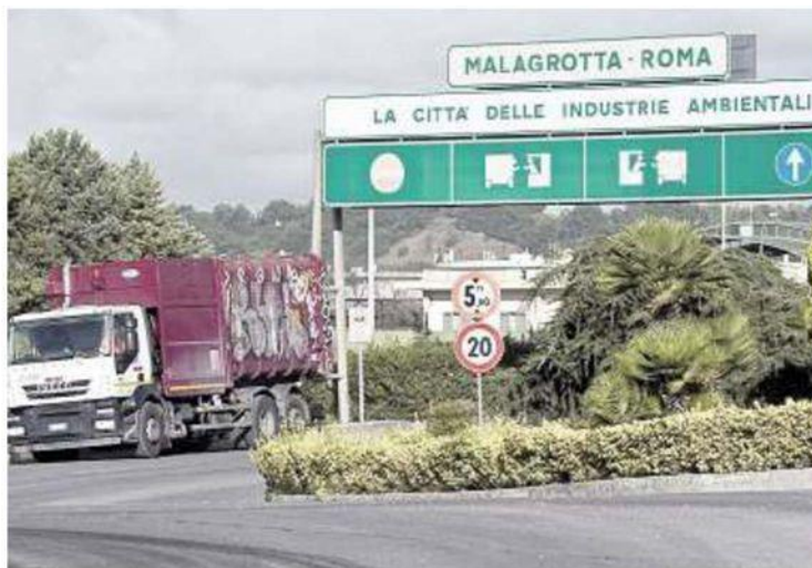
L'entrata dell'impianto di trattamento di Malagrotta
