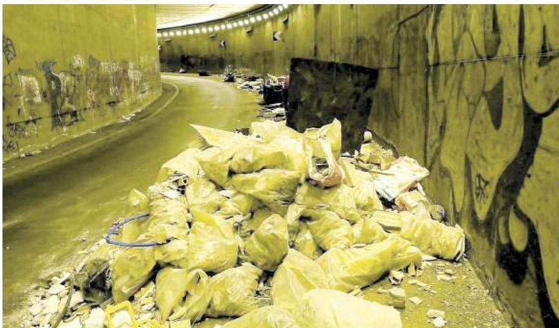
La distesa di rifiuti nel tunnel chiuso al traffico a Tor Vergata (foto TOIATI/MASTROPIETRO)
